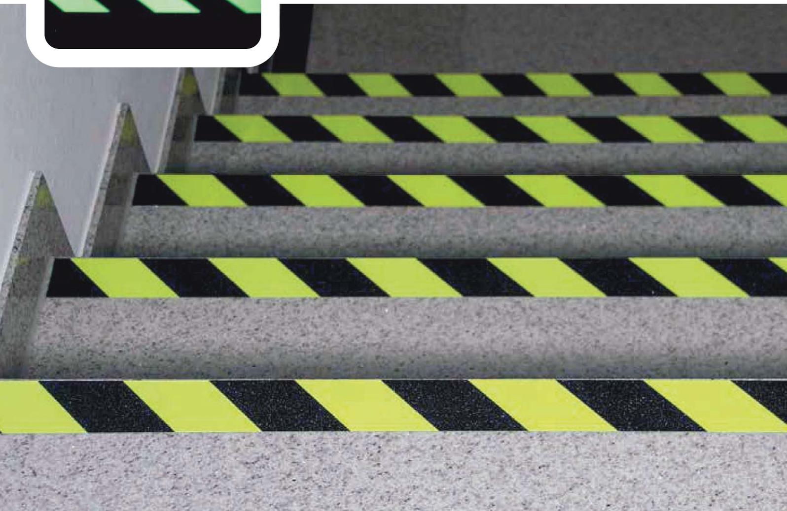
*Sie erhöhen die Traktion auf schrägen Oberflächen, Treppen und anderen Bereichen, wo Rutschgefahr besteht.*
