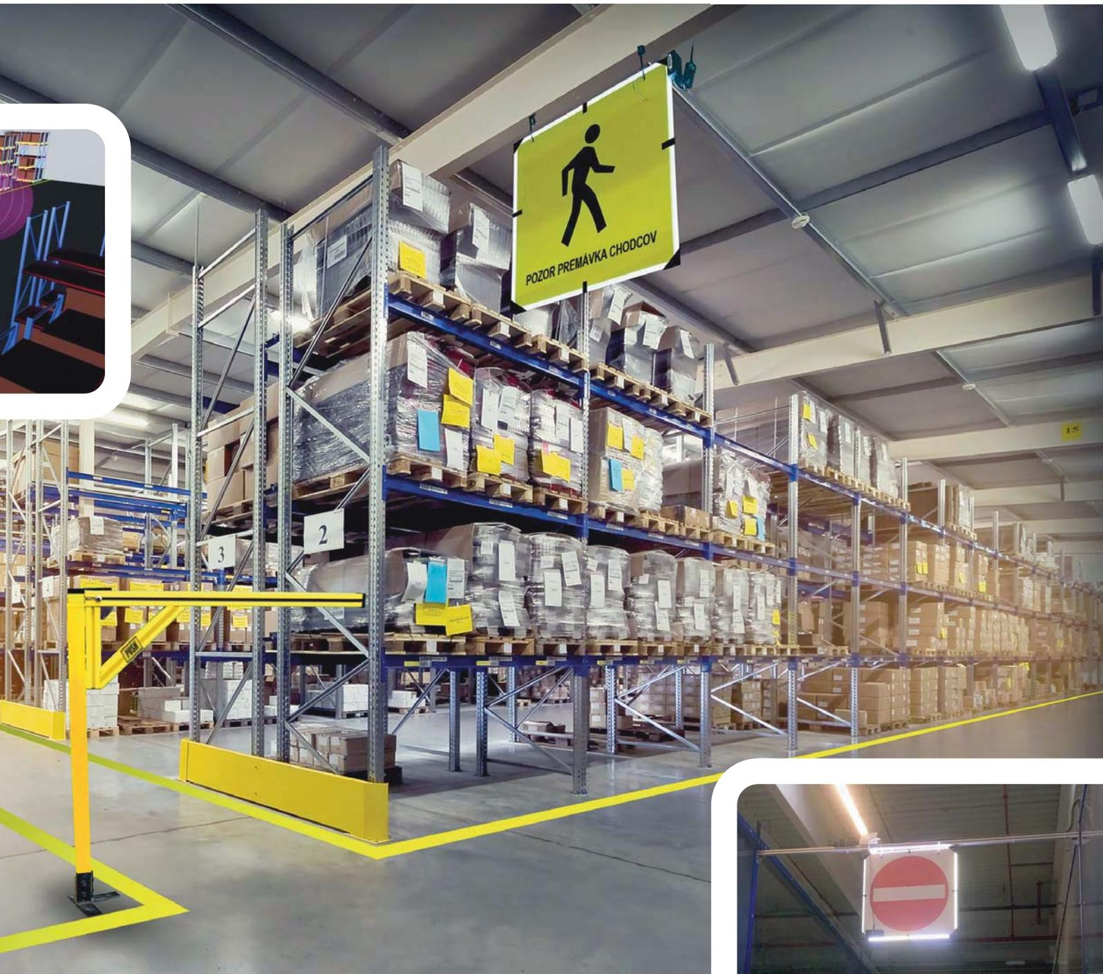
*LED-Markierungen sind sensorisch und kinetisch erhältlich. Der Bewegungssensor wird zu den am meisten frequentierten Orten positioniert und sendet beim Bewegung Signal zur LED-Markierung.*
